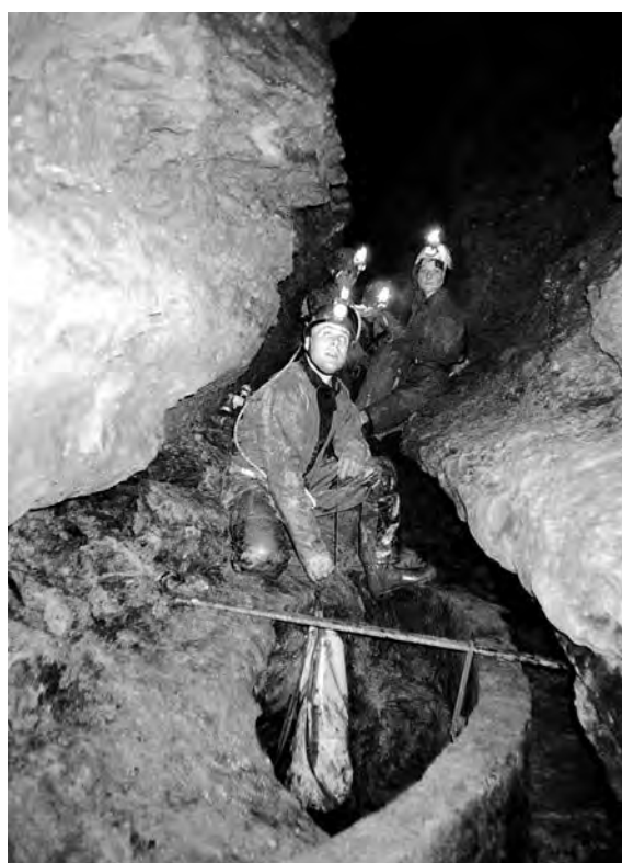
Puits d'accès (bure n°1) à la grotte de Mazenay, Saint-Sernin-du-Plain, Saône-et-Loire. Noter le petit mur maçonné empêchant la rivière souterraine de se déverser dans la mine sous-jacente (cliché Pierre Laureau).
